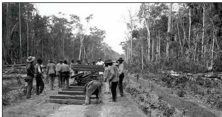
Trabalhadores assentando trilhos da EFMM
