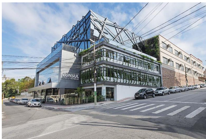
Em primeiro plano as modernas instalações do Colégio Cônsul, recém inauguradas, que se integram ao prédio antigo.
